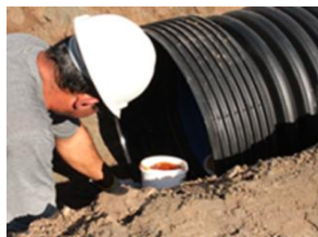
Figura 38 - Aplicação da pasta lubrificante
